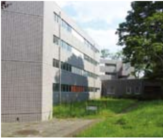
▲ エンパワー寮外観
